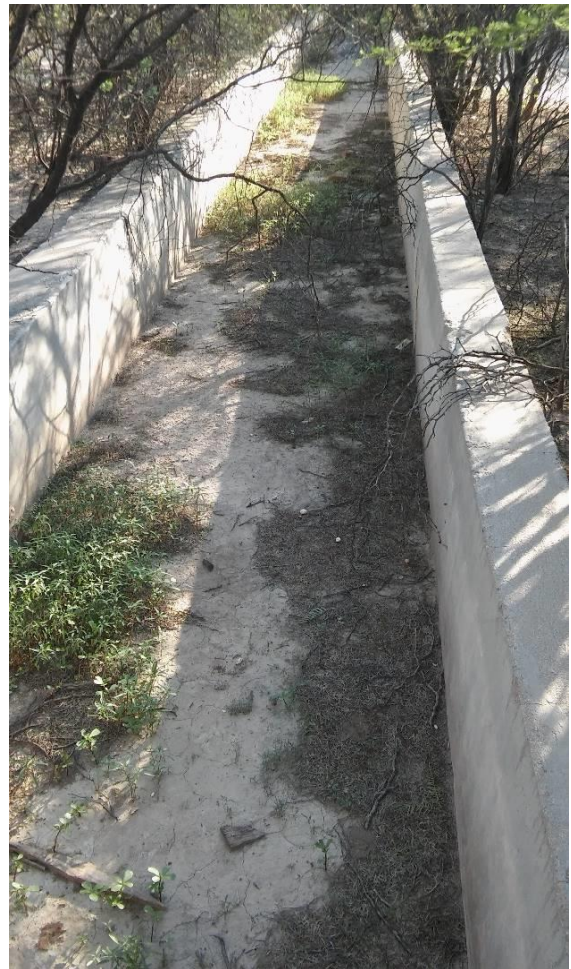
Figura 28. Vieja canaleta de agua.
